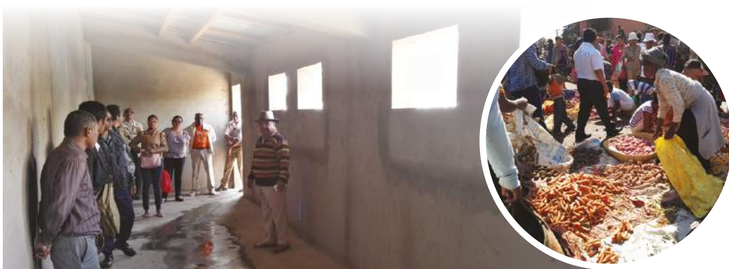
Visite du marché et suivi des travaux par le comité multi-acteurs, Madagascar
