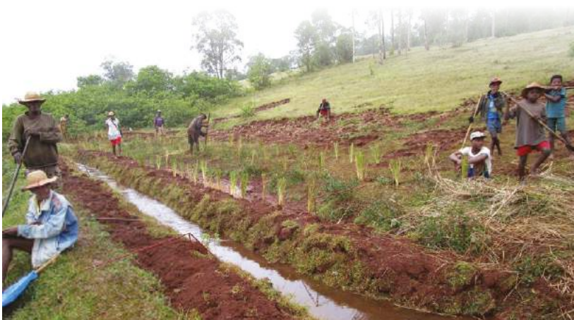
Aménagement antiérosif des abords des canaux d'irrigation, Madagascar
