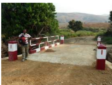
Amélioration des voies
