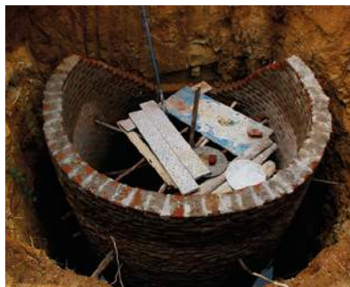
Construction d'un puits, Sri Lanka
