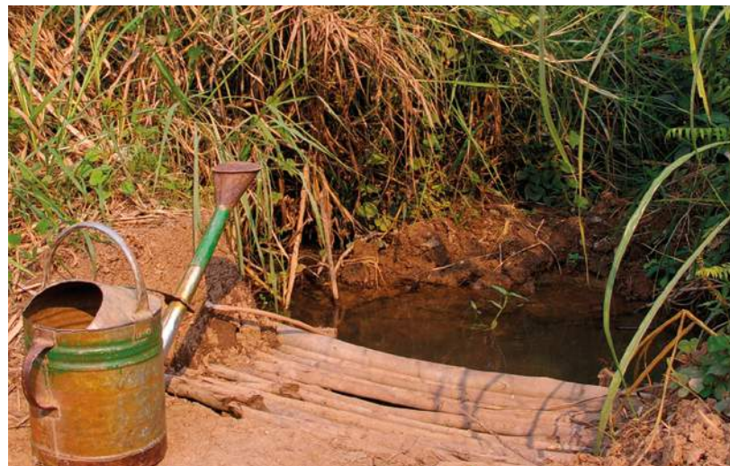
Point de captage aménagé, RD Congo
