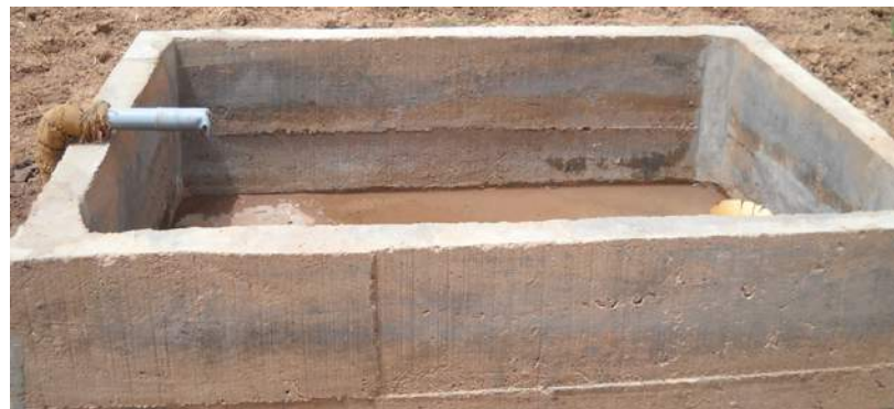
Bassin de reprise, Niger
