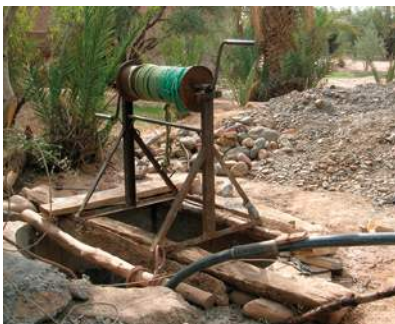
Construction d'un puits, Maroc
