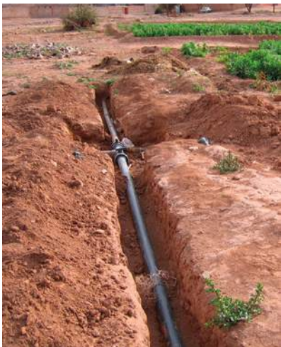
Canalisation PVC enterrée, Maroc
