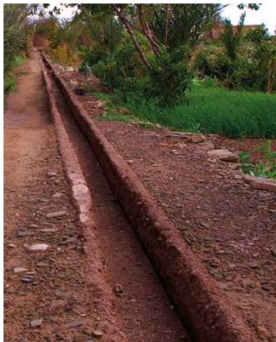
Canal bétonné, Maroc
