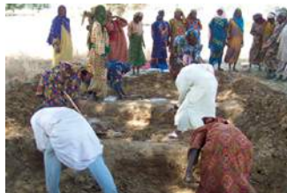
Réalisation des fosses à compost, Niger
