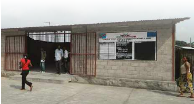
Construction d'une aire de stationnement et hangar de stockage de gros, RD Congo
