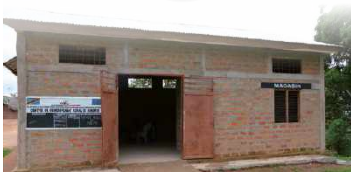
Construction d'un centre de regroupement rural, RD Congo
