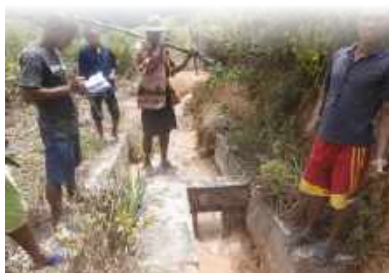
Visite de contrôle de la fonctionnalité des ouvrages
